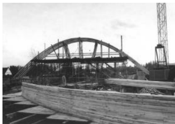
Abb. 4.2.12: Wohnhaus X1, im Bau, 1962 Q: PNF
