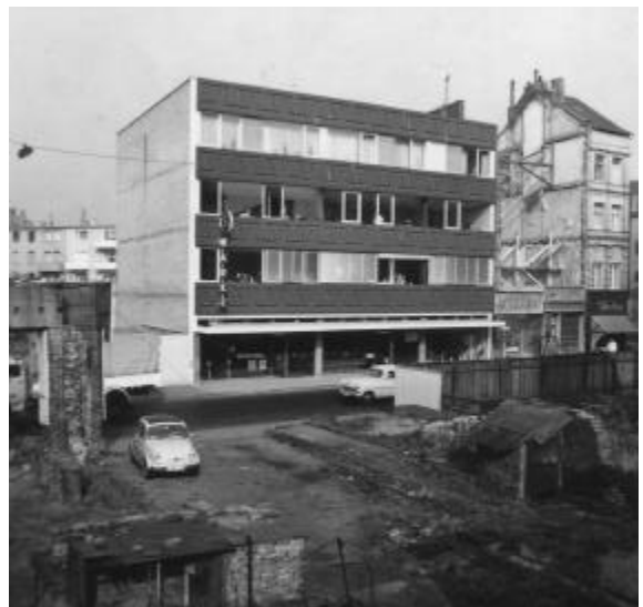
Abb. 6.1: Büro Weyerstraße im Bau, 1960 Q: PNF
